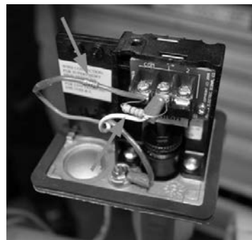
Նկար 3 ճնշման ռելեի հենամարմնում դիմադրությունների (ռեզիստորների) տեղադրման օրինակ
